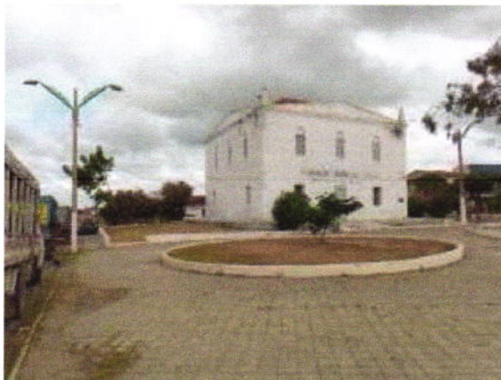
Edificação a ser mantida - Fundação Bernardo Feitosa
