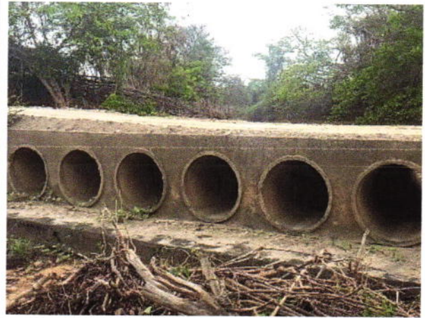
Visão dos tubos a demolir
