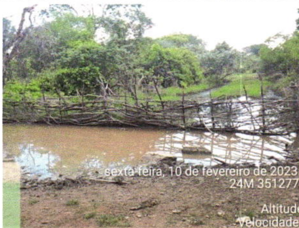
Visão geral da passagem do rio
