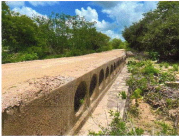
Visão da Passagem existente a ser demolida.
