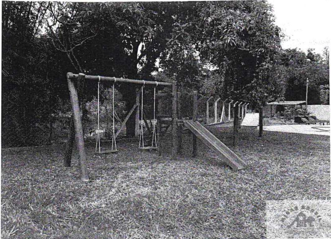
Confeccionada em eucalipto tratado e autoclavado de 10 a 12cm envernizado com stainou similar.
