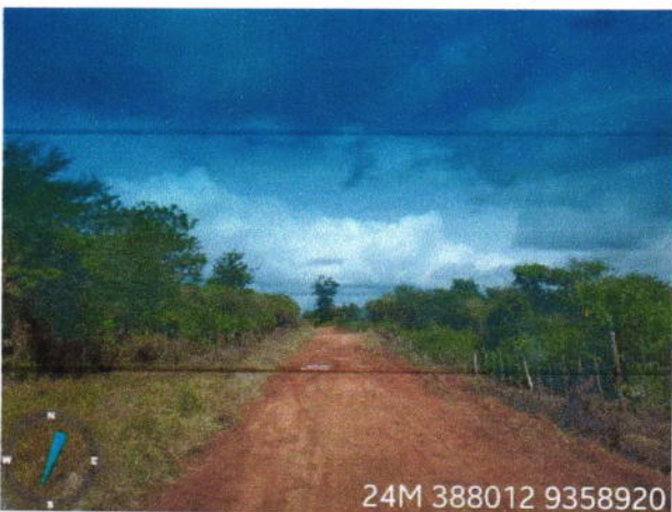
Visão geral da estrada
