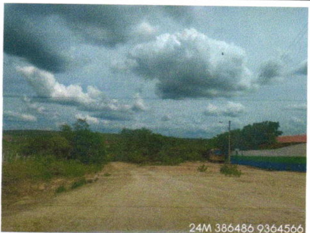
24M 386486 9364566 Visão geral da estrada próxima a escola
