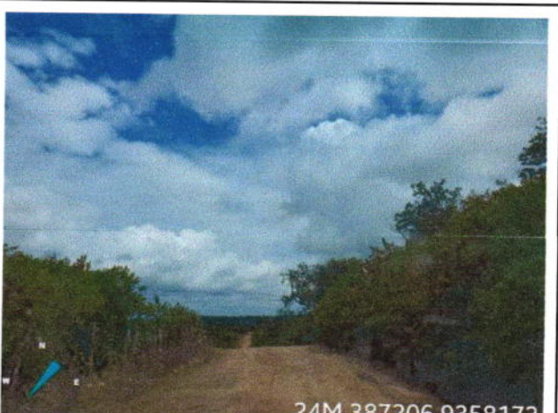
Visão geral da estrada
