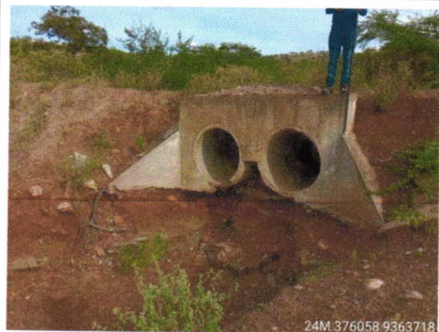
24M 376058 9363718 Bueiro existente a ser substituído
