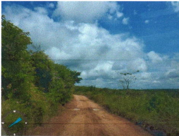
Visão geral da estrada
